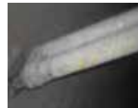
Trasig koppling, skadad och oxiderade rör och gängor
